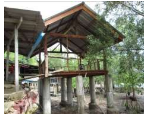
ภาพที่ 2 เสาปูนทำฐานโรงเพาะปูม้า
