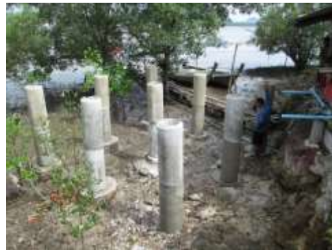
ภาพที่ 2 เสาปูนทำฐานโรงเพาะปูม้า
