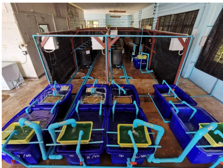
ภาพที่ 2 ระบบถังเลี้ยงแม่พันธุ์กุ้งที่ติดตั้งพร้อมระบบบำบัดน้ำ และระบบถังพักไข่
