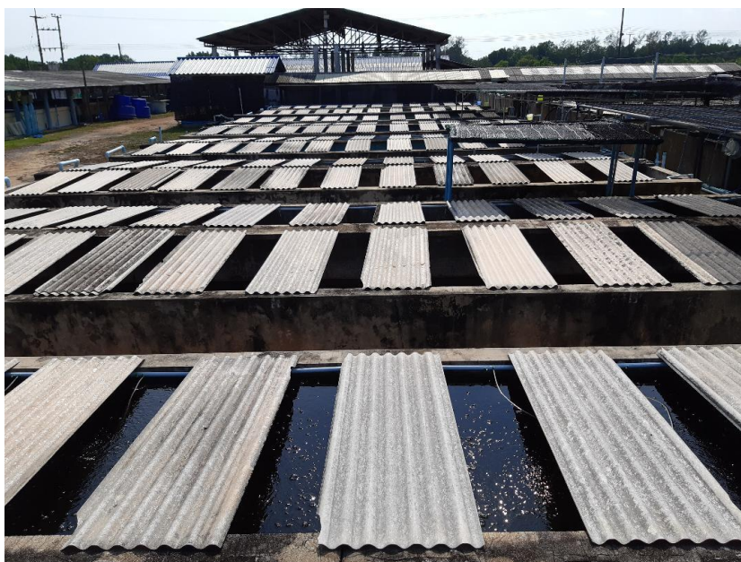
ภาพที่ 4 ปอคอนกรีตกลางแจ้งขนาดความจุ 12 ลูกบาศก์เมตร รวม 15 ปอ สำหรับเลี้ยงอาร์ทีเมียตัวโต
