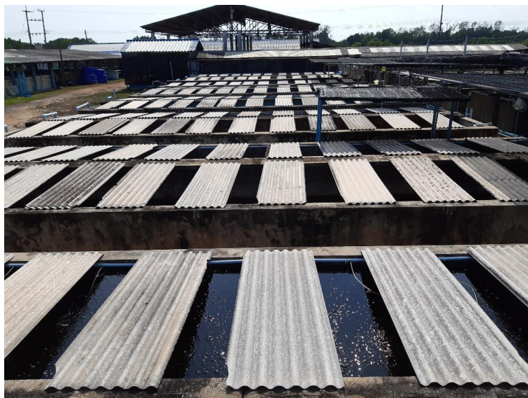
ภาพที่ 3 บ่อคอนกรีตกลางแจ้งขนาดความจุ 12 ลูกบาศก์เมตร รวม 15 บ่อ สำหรับเลี้ยงอาร์ทีเมียตัวโต
